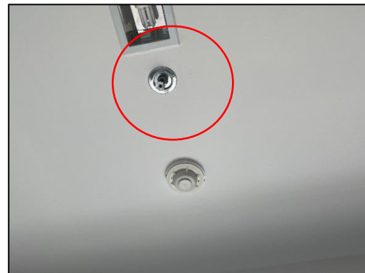
รูปที่ 1-29 Sprinkler
