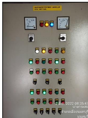
รูปที่ 1-10 ตู้ควบคุมระบบบำบัดน้ำเสีย
